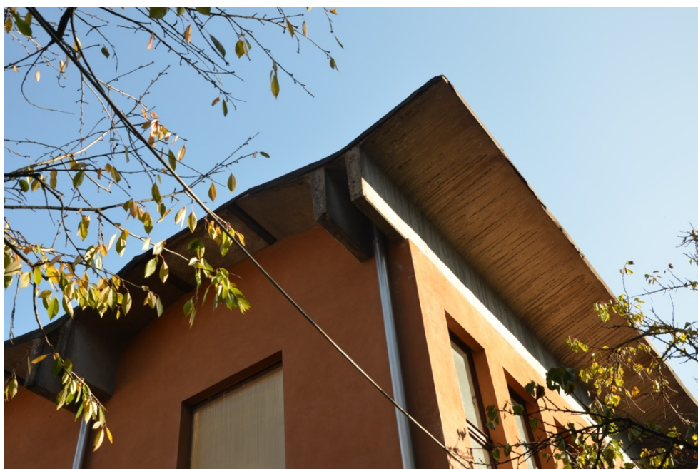
- Vista particolare tegolo di copertura in c.a.p. – LOTTO C -
